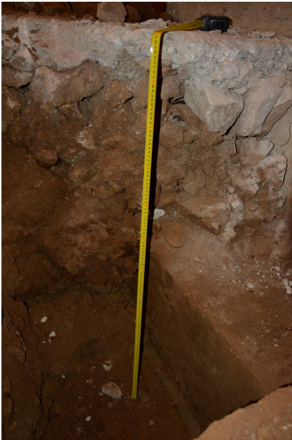
Foto 2. Vundamentide alapinnad on umbes meetri sügavusel keldri põrandast
